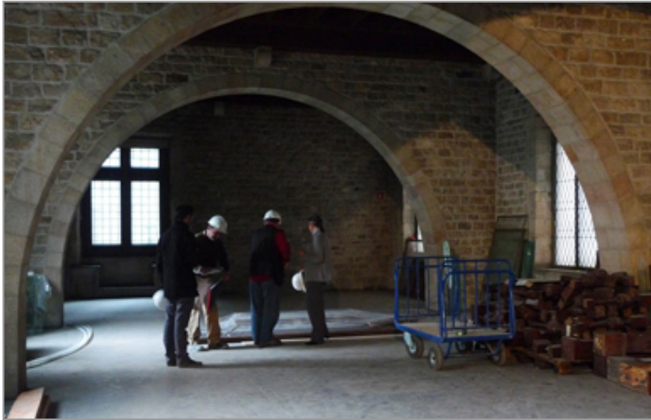
Visita d'obres. Sala 14
