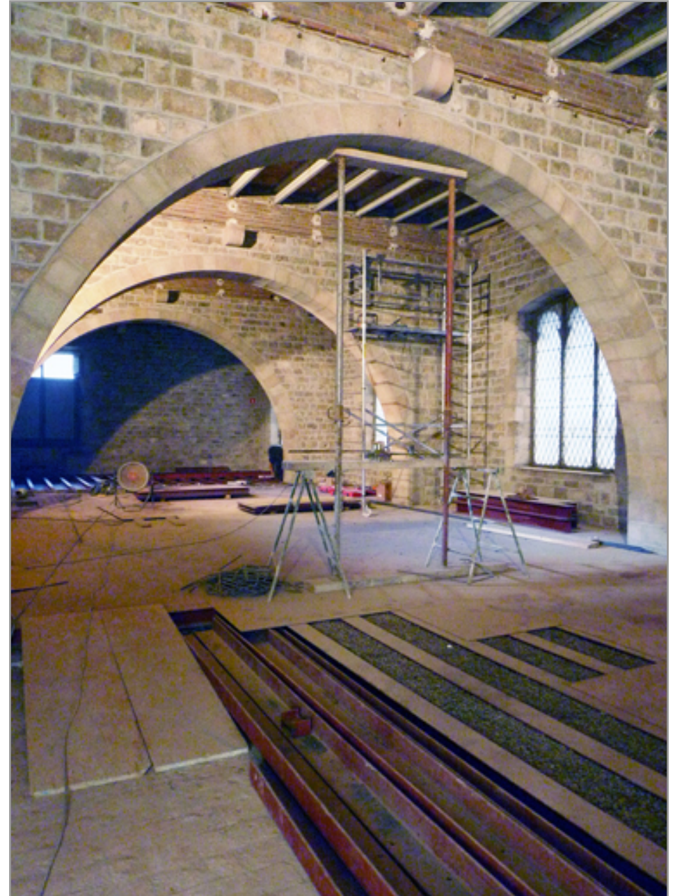
Procés de remodelatge de la Sala 14. Construcció del nou forjat
