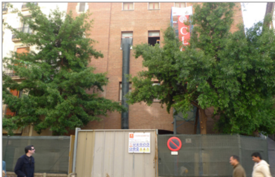
Accés posterior a l'obra. Retirada de la runa
