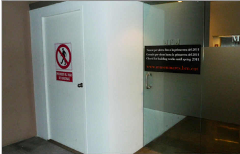
Accés del personal a l'obra
