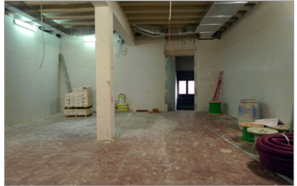
Procés de remodelatge de la Sala 27
