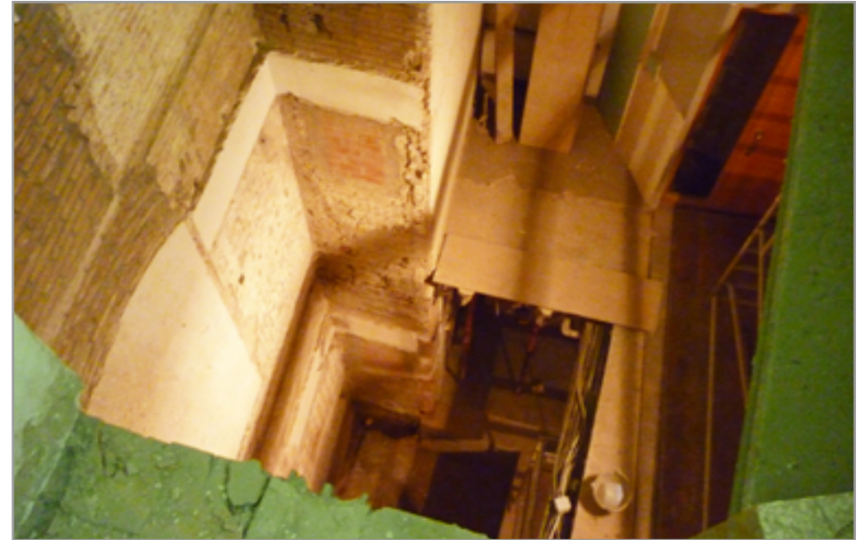
Forat per instal·lar el muntacàrregues
