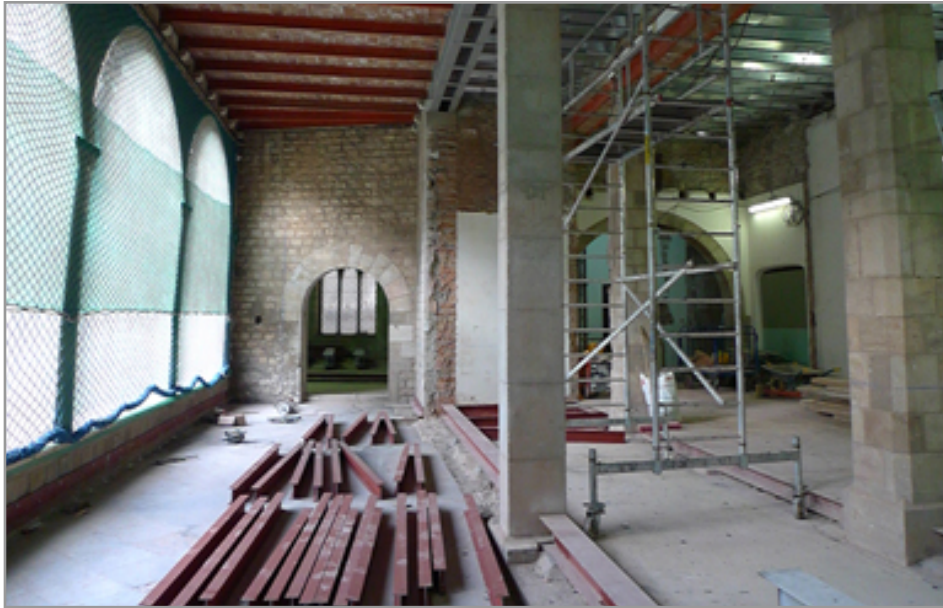
Procés de remodelatge de la Sala 15
