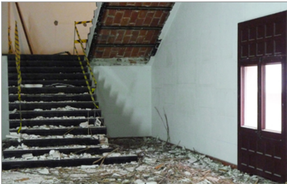
Eliminació d'una escala d'accés del primer al segon pis
