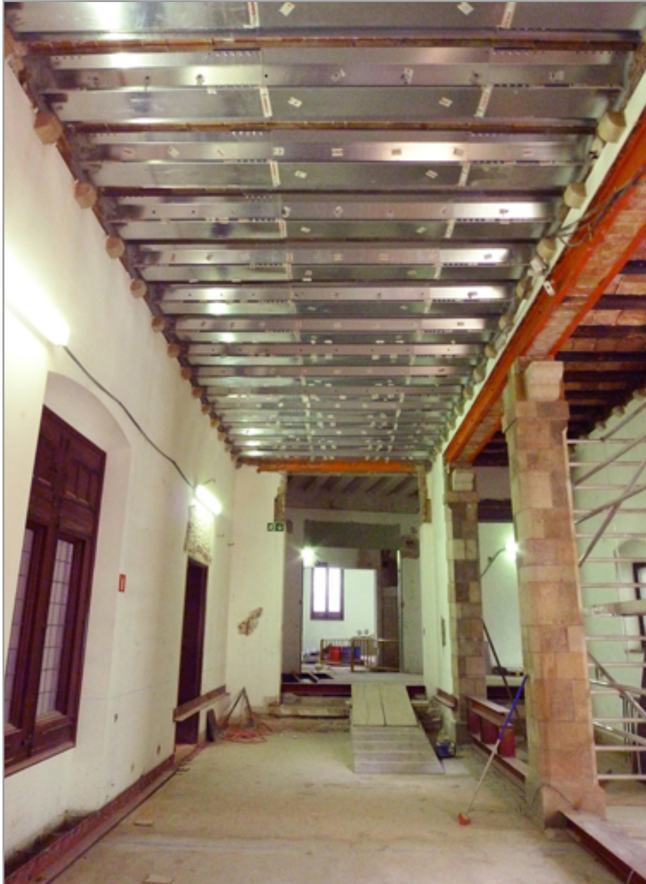
Protecció i encapsulament de les bigues del sostre. Sala 15
