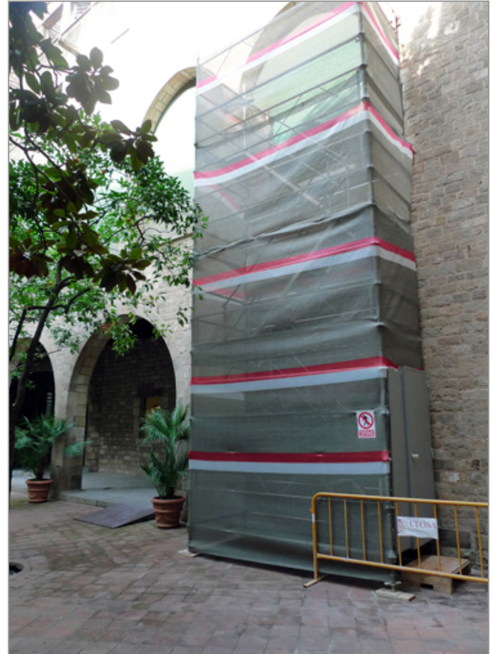
Nou accés a l'obra pel pati del Museu
