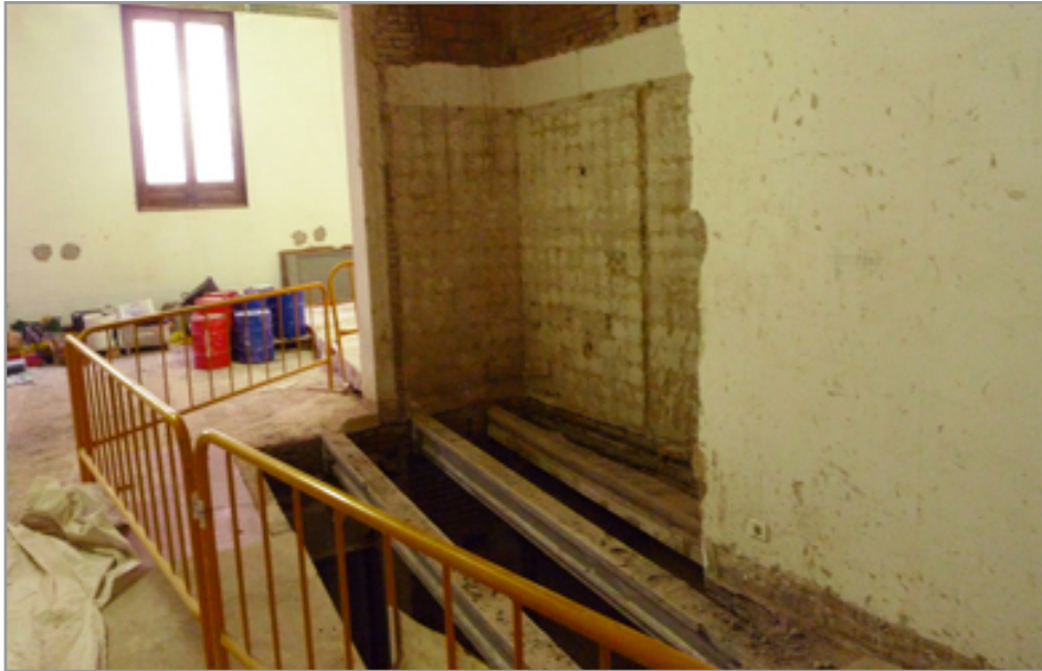
Obertura a totes les plantes de l'orifici on s'ha d'instal·lar el muntacàrregues
